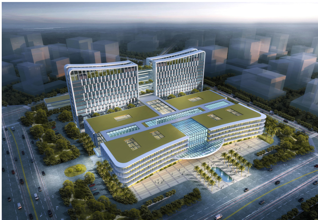
（在建中的新院区）
