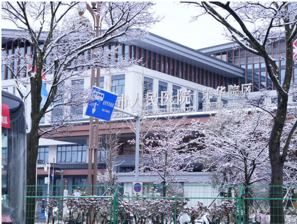
丽江市人民医院荣华院区
